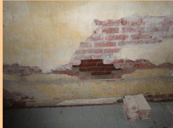
Zweischaliges Mauerwerk mit Hohl-schicht
