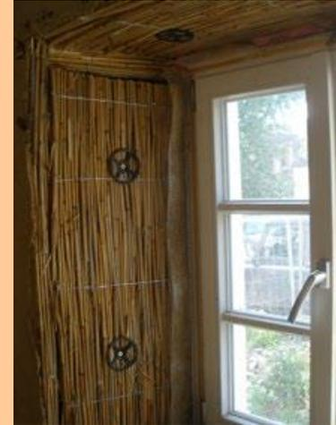
Innendämmung mit Schilfrohr
