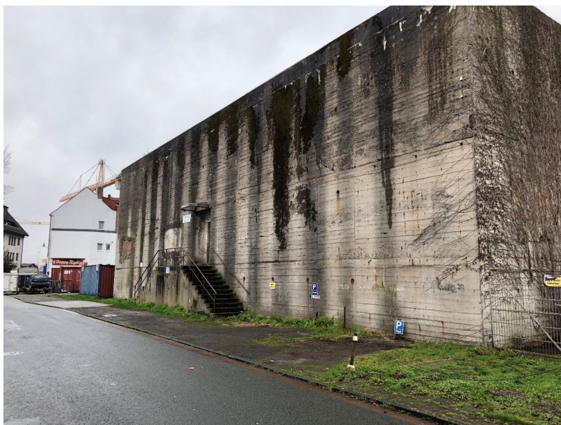
Der Luftschutzbunker aus der NS-Zeit in der Leutweinstraße (Leutweinplatz), Bremen-Walle. Im Hintergrund der Nachtclub "Happy Night". © 2020 F. Thomas Gatter.
